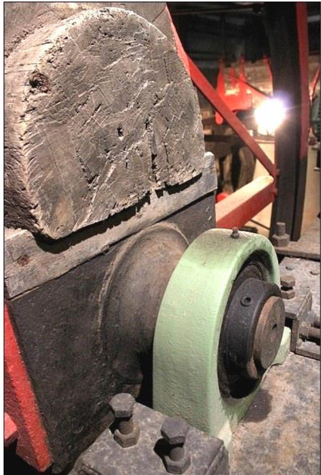
Roulement à billes d'un palier de cloche rénové
